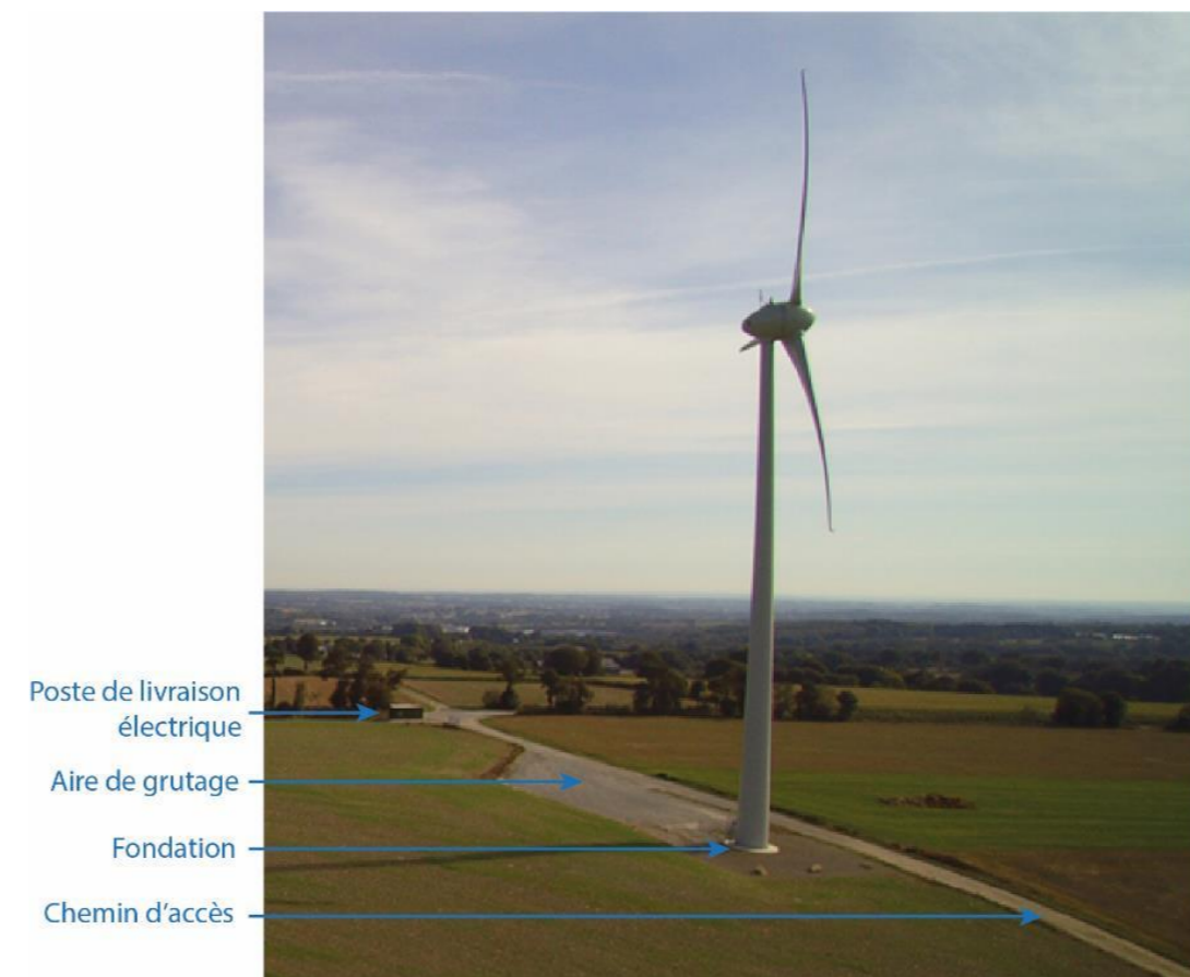
Photo 2 : une éolienne et ses aménagements annexes (AEPE Gingko)
